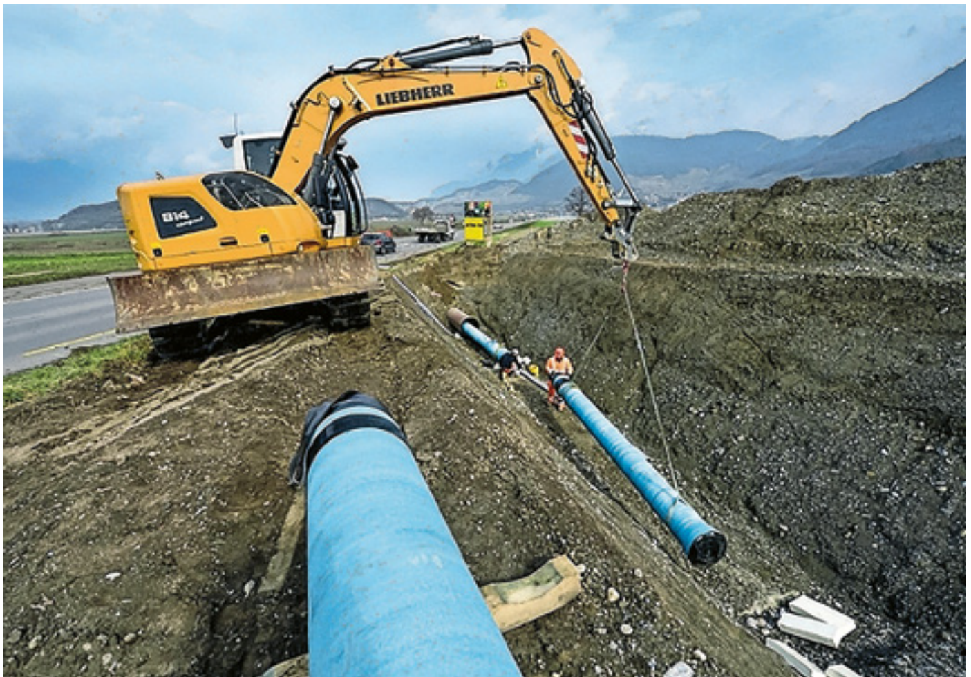
Travaux de pose de la nouvelle conduite d'adduction et passage sous la route principale.
