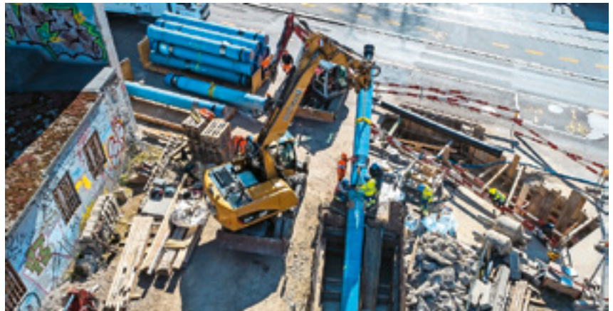
Der Einzug der FZM/BLS-Rohre DN 600 mm.
