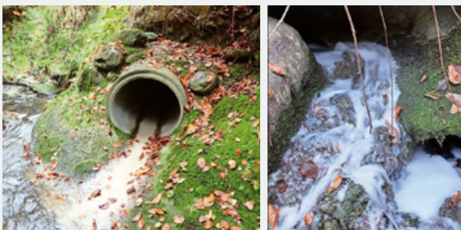
Fig. 3 Exemple de pollutions aux eaux usées pouvant être attesté lors de la visite par observation organoleptique (matière fécale, lessive).
