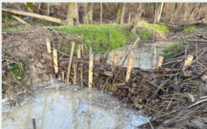
Fig. 6 BDA kurz nach der Erstellung, mit Wasserpegelanstieg um rund 10–15 cm. Der Pegelanstieg bewirkt einen Anstieg des Grundwassers (vgl. Stadium A, Fig. 2). Seriell eingebaut, kann der Wasserrückhalt selbst in kleinen Bächen stark vergrössert werden. (©S. Minnig)
