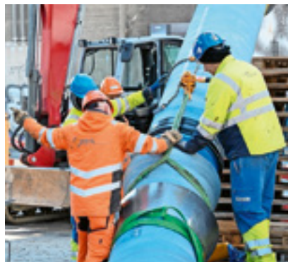
Die Montage wird fachkundig durch die Monteur der Wasserversorgung Zürich ausgeführt.
