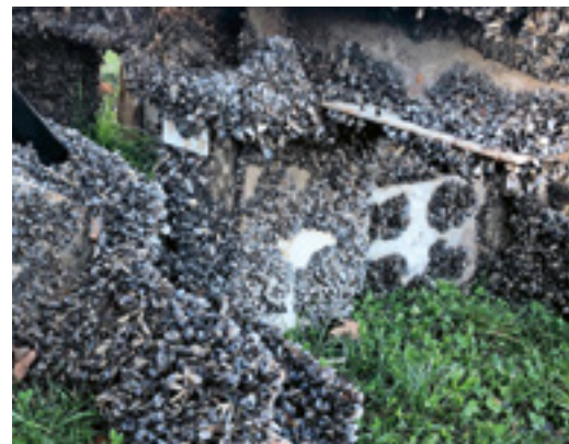
Die Quaggamuschel fühlt sich im Wasser auf fast allen Oberflächen wohl: hier auf Trägern der Seebühne Bregenz. (©Thomas Blank, Abteilung Wasserwirtschaft Vorarlberg)
