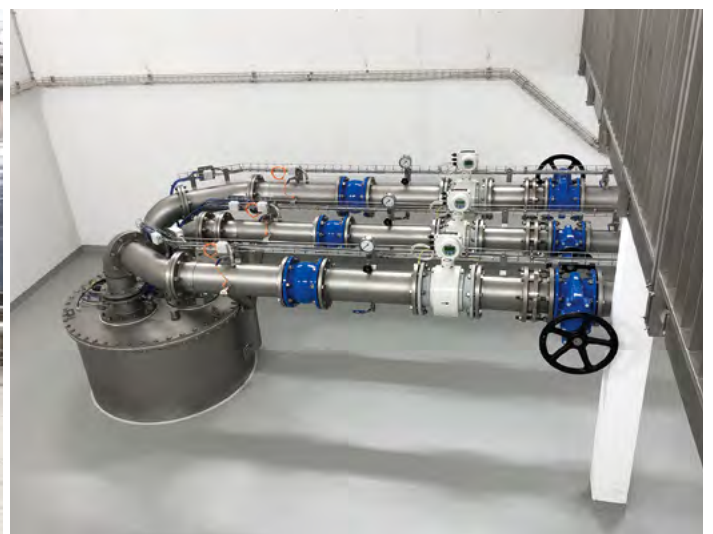
Das Innenleben eines Grundwasserpumpwerks: ein Zusammenspiel aus Pumpen und Armaturen. Die Absperrrklappen, Rückflusssperren und Schieber stammen von Erhard/Hagenbucher.
