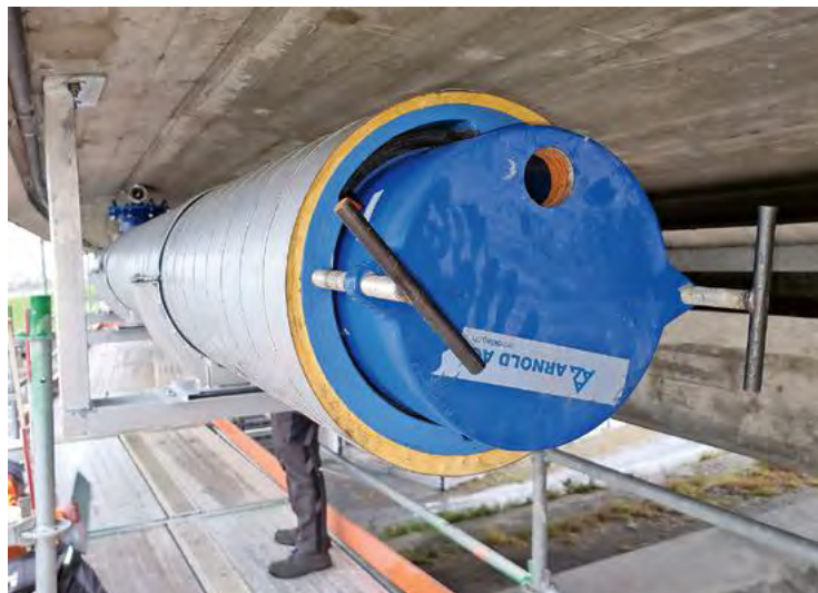
Einfaches Verschliessen durch P-Stopfen an der aufgehängten Leitung.
